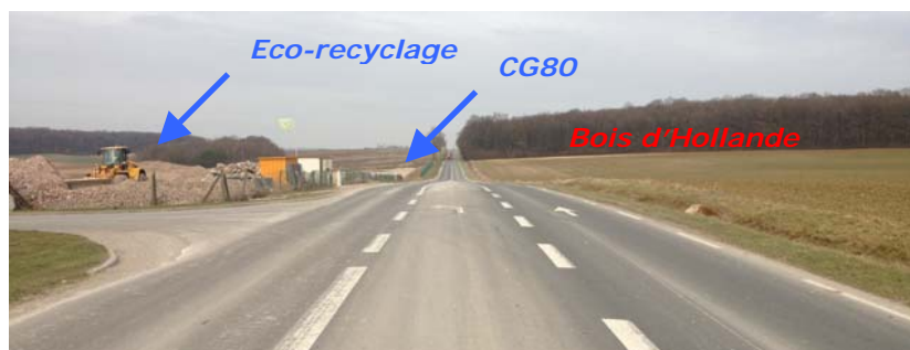
Photo 9 : entrée de la déchetterie et vue sur l'entreprise de recyclage
