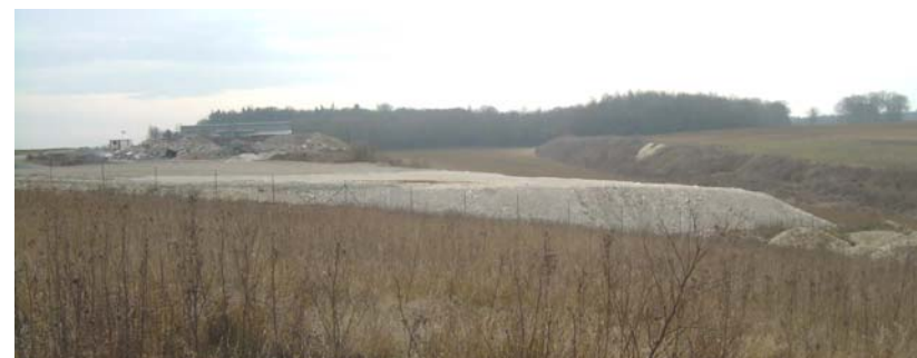
Photo 6 : remblai volumineux et clair en direction de la vallée Billon
